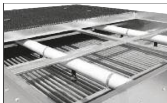
Separatori di gocce rimossi per l'ispezione alla batteria
