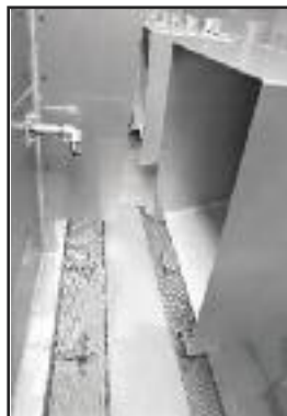
Separatori di gocce rimossi per l'ispezione alla batteria
