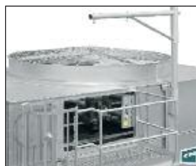
Raffreddatore Ibrido eco-ATWB-H dotato di piattaforma di servizio e paranco
