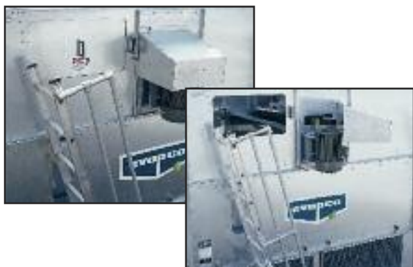
Montaggio esterno del motore (con scaletta opzionale)
