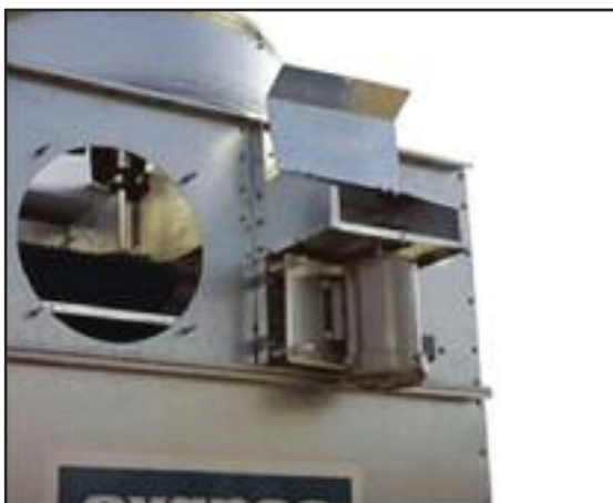
Montaggio esterno del motore
