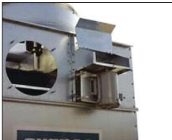
Außen montierter Motor (mit aufklappbarer Haube)
